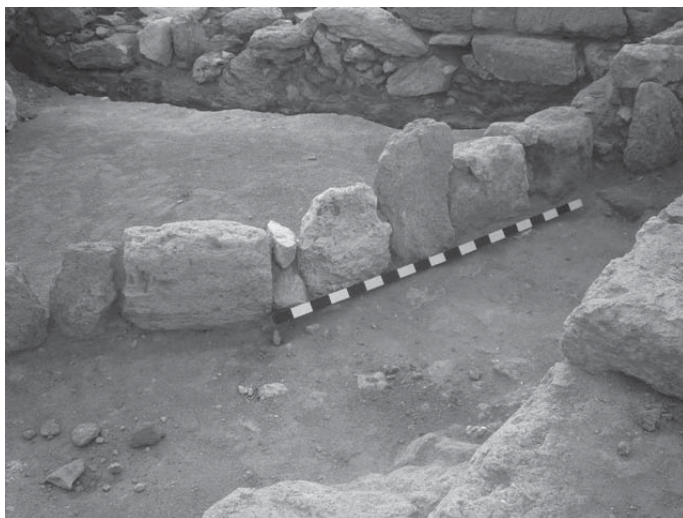
Рис. 1. Водосток, расположенный вблизи Западной башни. Юго-западный фас.
