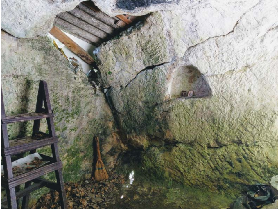
Рис. 6. Церковь на поляне Кильсе-тубю. Северо-западная стена
